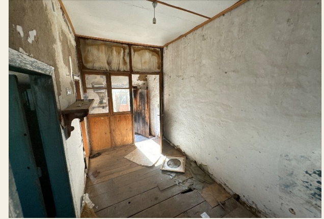
İç hacim: ahşap döşeme, giriş aksı ve restore edilecek yüzey katmanları.
